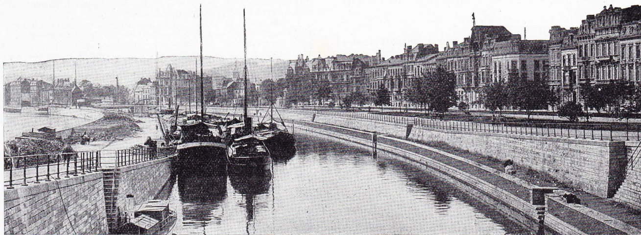
Liège. — Boulevard Frère-Orban et le chenal de l'écluse vus du pont du Commerce.
